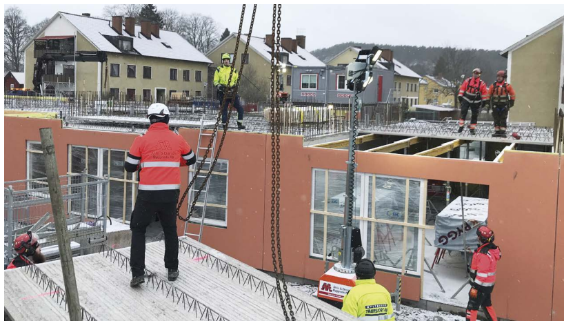
Väggarna levereras färdigbyggda, med fönster och fasadfärg på plats. Bilden tagen i februari. Foto: Kjell Ottosson
